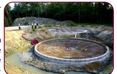
Le clarificateur et le bassin d'aération en cours de réalisation
