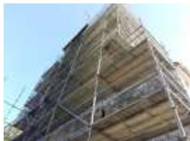
Les travaux ont débuté par l'installation d'un échafaudage permettant à tous les ouvriers et artisans de travailler en toute sécurité. Cette installation a duré un mois au vu de la hauteur de l'édifice.
